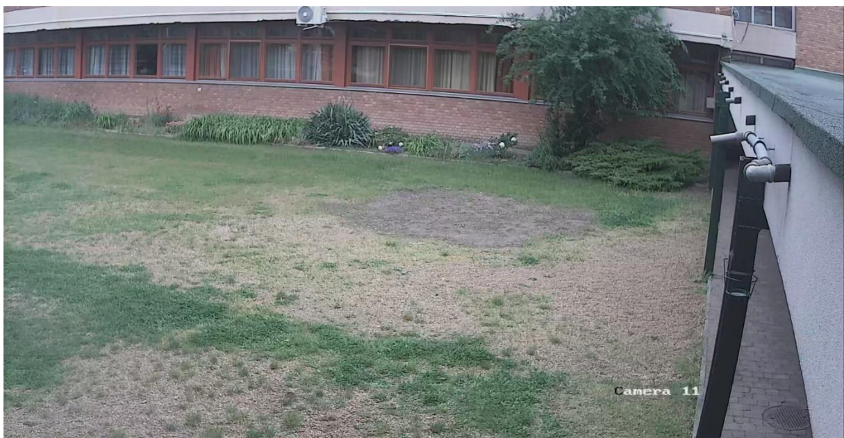
Iskola épület földszinti ablakok 2 (külső kamera)
