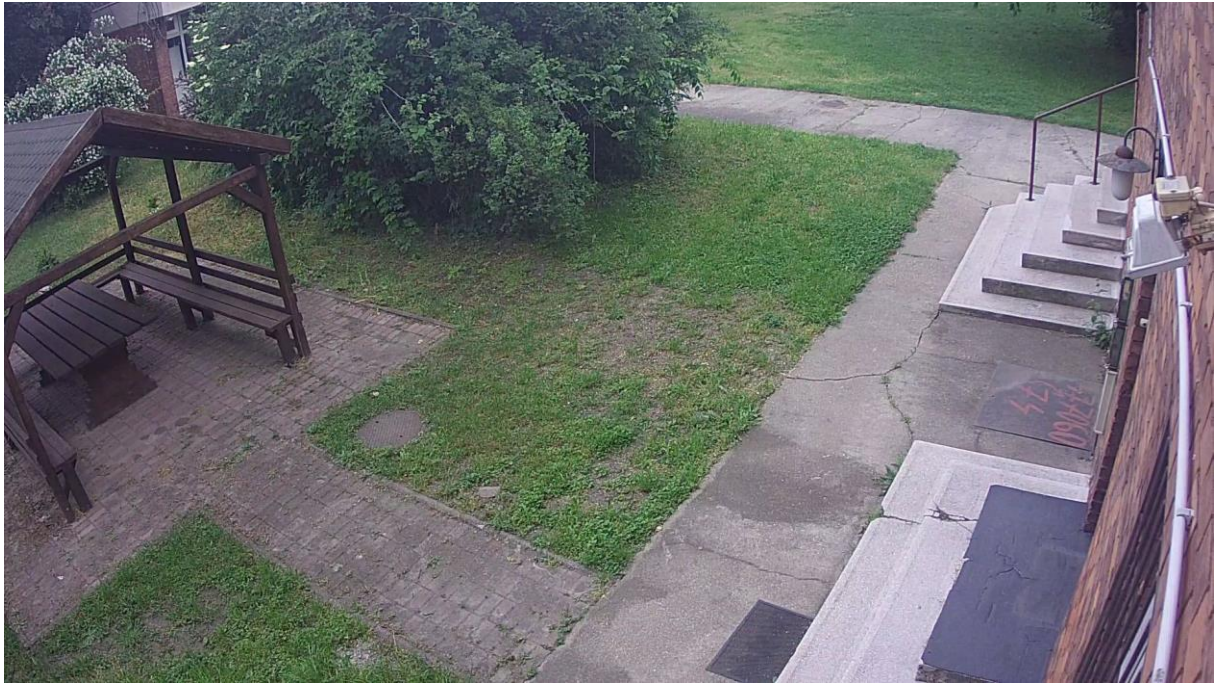
Módszertani épület lépcső feljárata (külső kamera)
